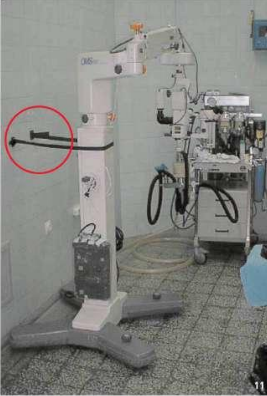
Fotoğraf 11: YOTA uygulamaları. Ameliyat mikroskopunun sabitleme çalışması. Bu tür cihazların tekerleklerinin kilitli olmasına dikkat edilmelidir. (İstanbul Polis Hastanesi).
