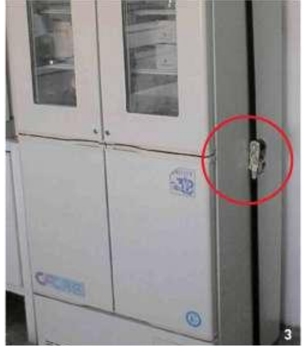
Fotoğraflar 1, 2, 3: Tıbbi cihazlarda YOTA uygulamaları. 1: Laboratuvardaki bir mikroskopun sabitlenmesi, 2: Sabitme elemanı, 3: Tıbbi bir soğutucunun sabitlenmesi (İstanbul Polis Hastanesi).
